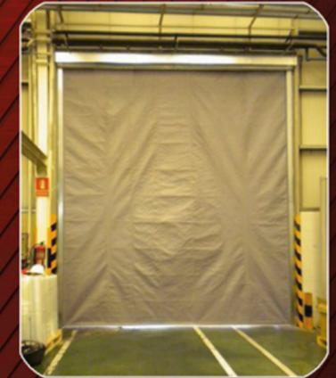
Fabricadas con textiles técnicos Parallamas (clasificación E), es necesario combinarlos con sistemas de irrigación de agua, para conseguir un conjunto cortafuegos con clasificación hasta EI-180.
