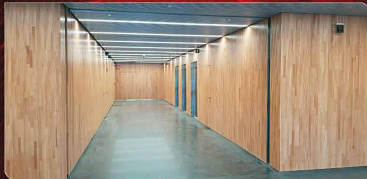
La capacidad de ser paneladas con diferentes materiales, permite mimetizarla con el acabado de los paramentos
